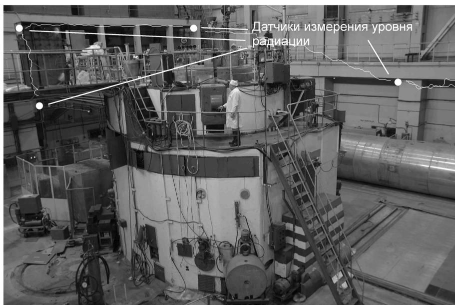
Иллюстрация 2: Схема сбора данных о радиационной обстановке при помощи РСС
