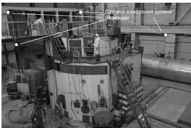
Иллюстрация 7: Схема сбора данных о радиационной обстановке при помощи РСС
